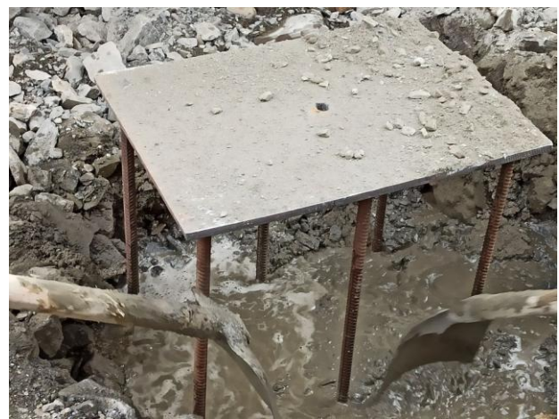
ფოტო 51-52. მდინარე მლეთის ხევის კალაპოტში რკინა-ბეტონის ფუნდამენტის მოწყობა
