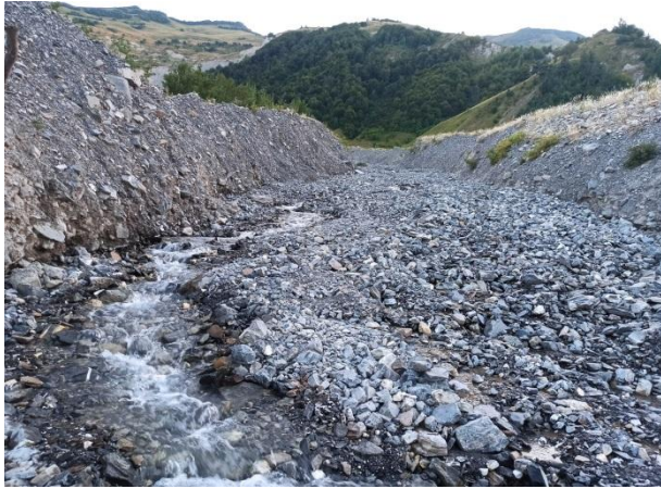
ფოტო 49-50. მდინარე ქვემო მლეთის ხევის კალაპოტში დროებითი სამშენებლო საექსპლუატაციო გრუნტის გზის გაყვანა
