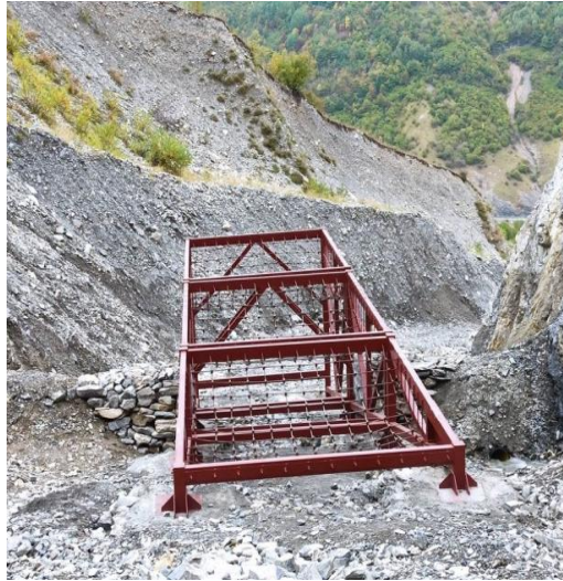
ფოტო 65-66. დასრულებული ღვარცოფსაწინააღმდეგო ნაგებობა მდინარე მლეთის ხევის კალაპოტში (დუშეთის მუნიციპალიტეტი)
