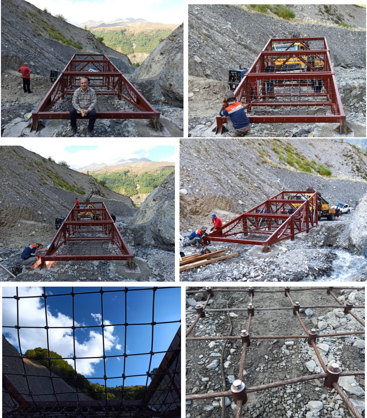
ფოტო 53-58. მდინარე მლეთის ხევის კალაპოტში (დუშეთის მუნიციპალიტეტი) დაიწყო ინოვაციური ღვარცოფსაწინააღმდეგო საცდელ-ექსპერიმენტული ლითონის კონსტრუქცია მოეწყო Photos 53-58. An innovative trial-experimental metal construction for anti-debris flow has begun in the bed of the Mleta river gorge (Dusheti municipality)
