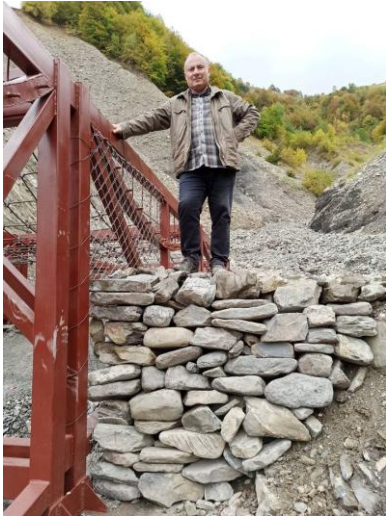
ფოტო 65-66. დასრულებული ღვარცოფსაწინააღმდეგო ნაგებობა მდინარე მლეთის ხევის კალაპოტში (დუშეთის მუნიციპალიტეტი)
