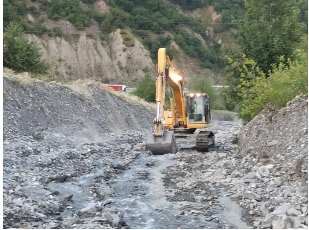
ფოტო 49-50. მდინარე ქვემო მლეთის ხევის კალაპოტში დროებითი სამშენებლო საექსპლუატაციო გრუნტის გზის გაყვანა
