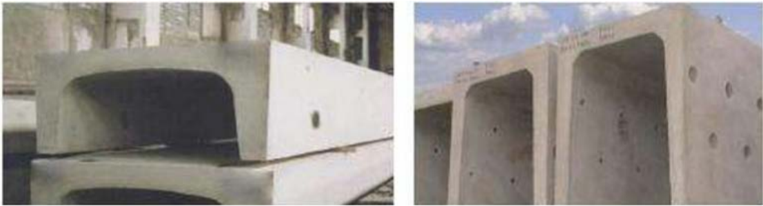
ფიგ. 5 ინვენტარული რკინაბეტონის ხიდის კონსტრუქციები
