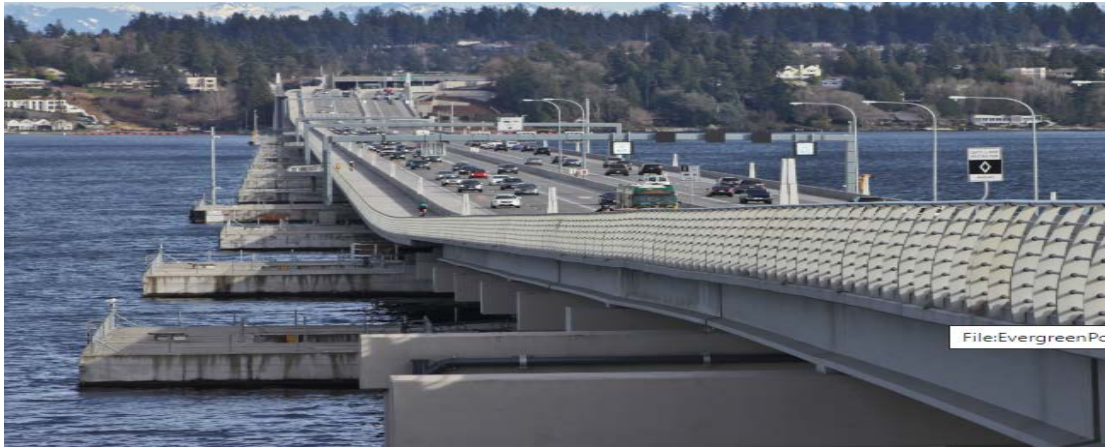
ფიგ. 7 მსოფლიოში ყველაზე დიდი პონტონის ხიდი. აშშ, ვაშინგტონი.
