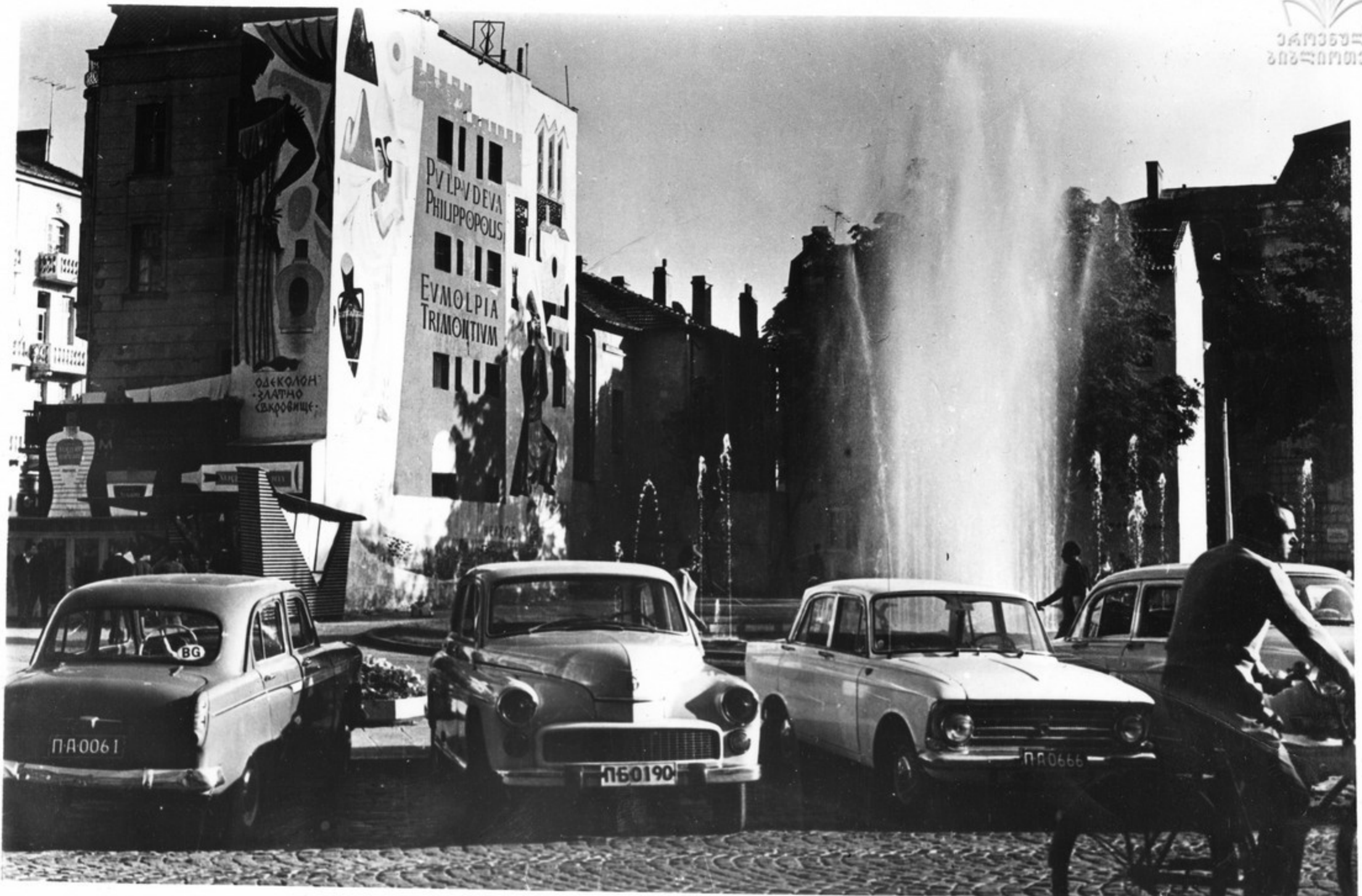
ბუღბუღათში რიდი ავტომობილებია საბჭოთა მანქანებზე. სუბათზე: „მოსკვიჩები“ ქალაქ პლავნივის ქუჩაზე.
