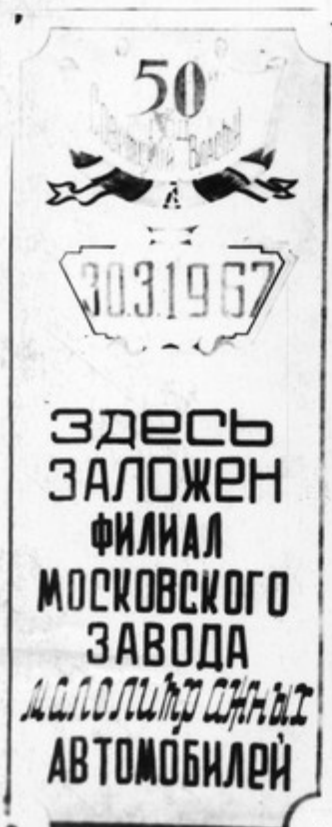
Закладка капсулы в фундамент.
