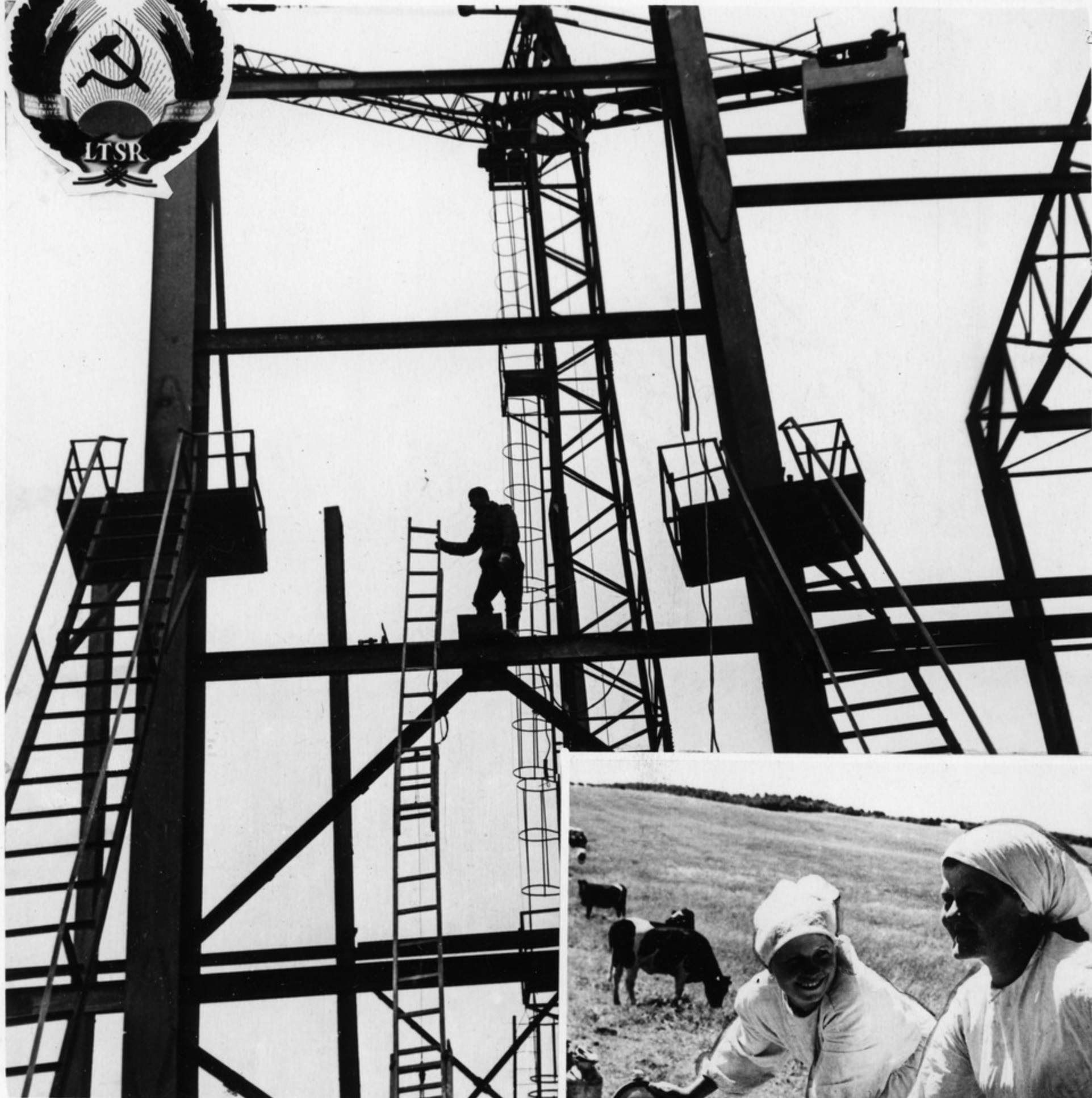
Строится цех фосфоритной кислоты Кедайнского химического комбината.
