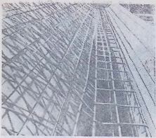
აქ ნაჩვენებია ხის ყალიბებში ჩაწყობილი ლითონის ღეროები კონსტრუქციის დამატონებამდე
