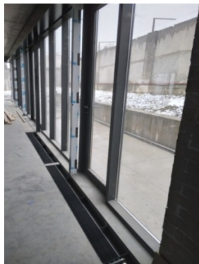
ნახ.8 შემინული ზედაპირების ჭავლური თბური დაცვა: ა-იატაკქვეშა არხული კონვექტორით ბ- დაბალი კონვექტორებით
