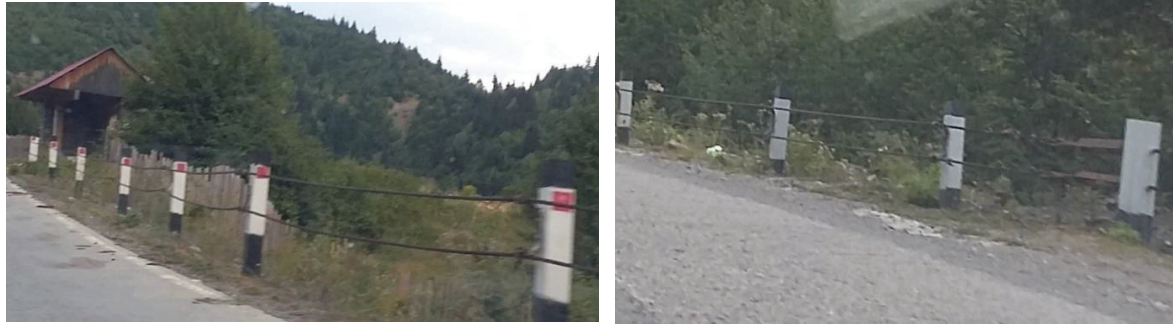
სურ. 1, 2. საბჭოთა სტანდარტით შესრულებული საზაგარო ბარიერები სამეგრელო - ზემოსვანეთის საგზაო მონაკვეთზე
