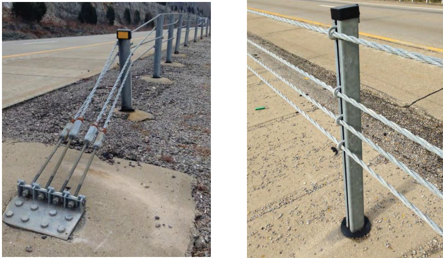
სურ. 3,4. საზაგარო ბარიერების კონსტრუქციული გადაწყვეტილებები ამერიკის შეერთებული შტატების მაგალითზე
