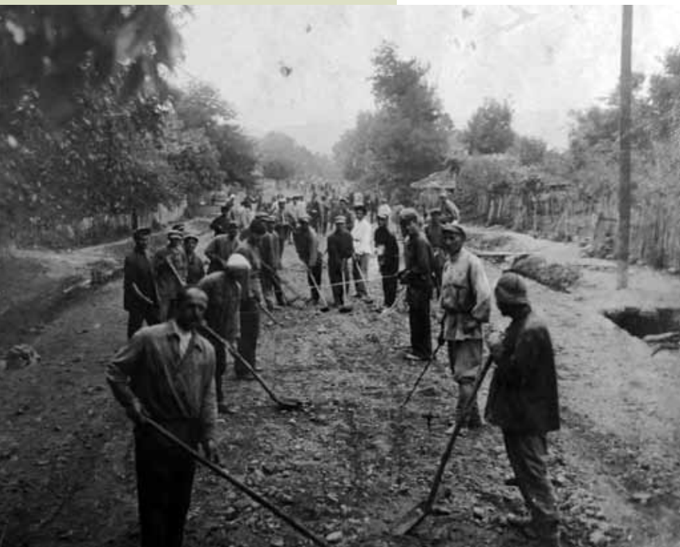
Строительство дорог под руководством дорожного мастера Иосифа Онанашвили
