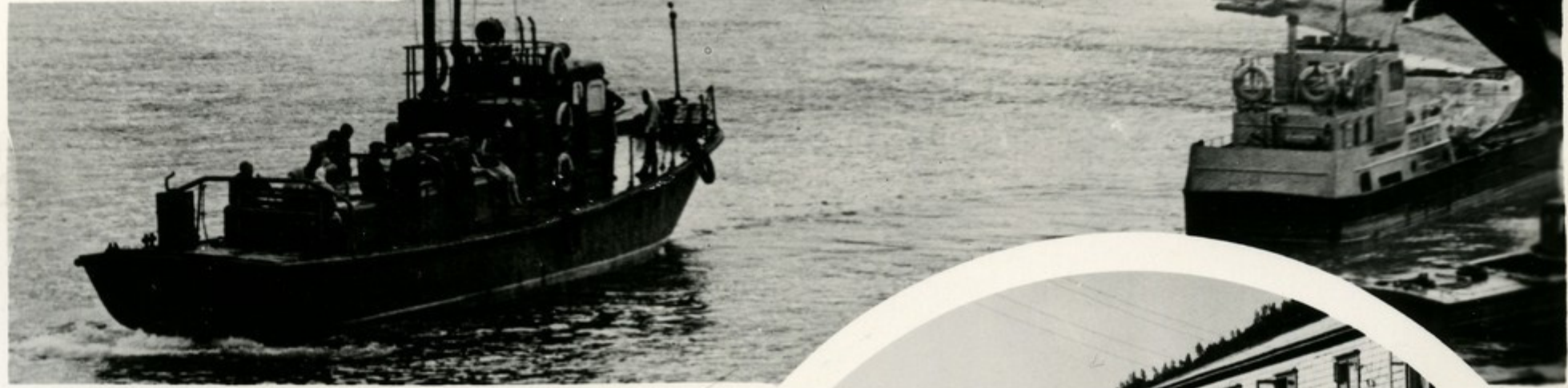
Причал у поселка Майна. Сюда прибывают грузы для стройки.
