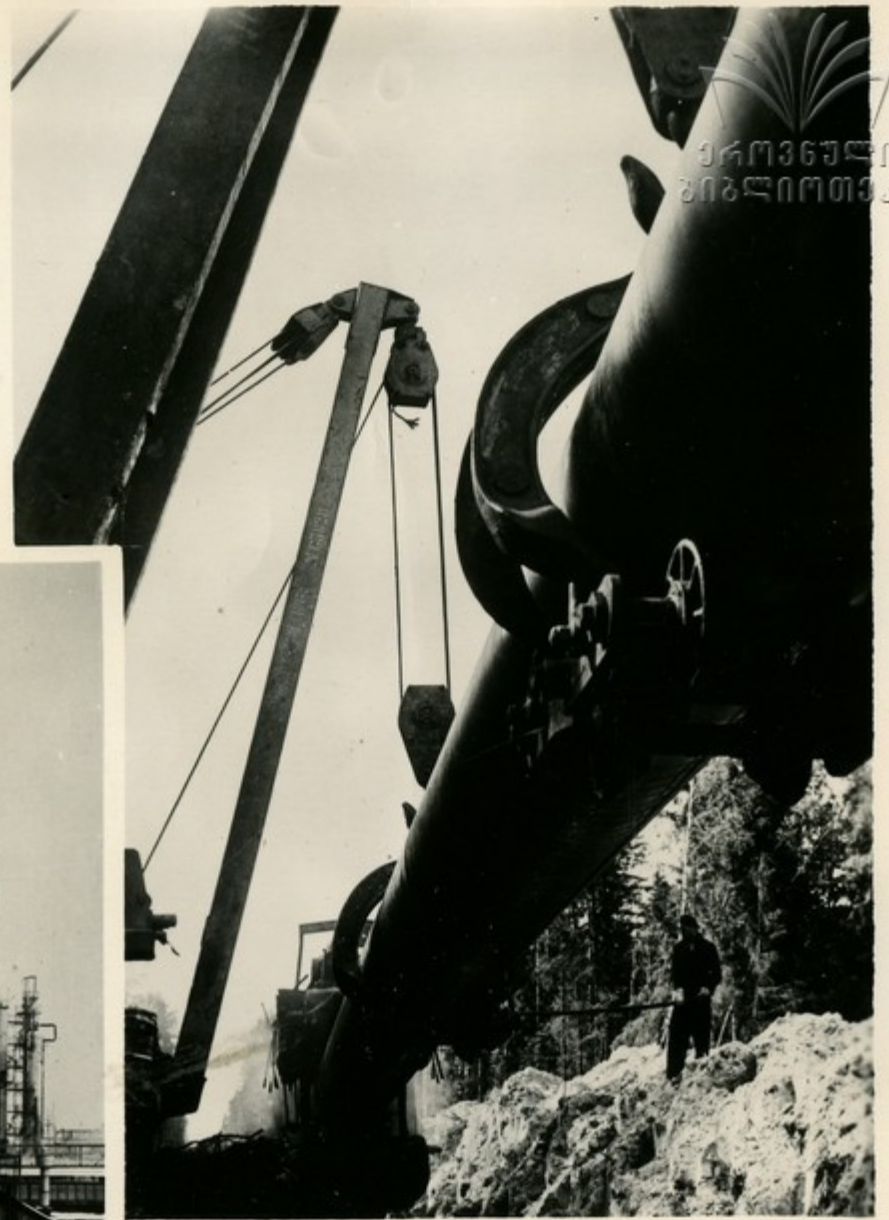
Укладка нефтепровода.
