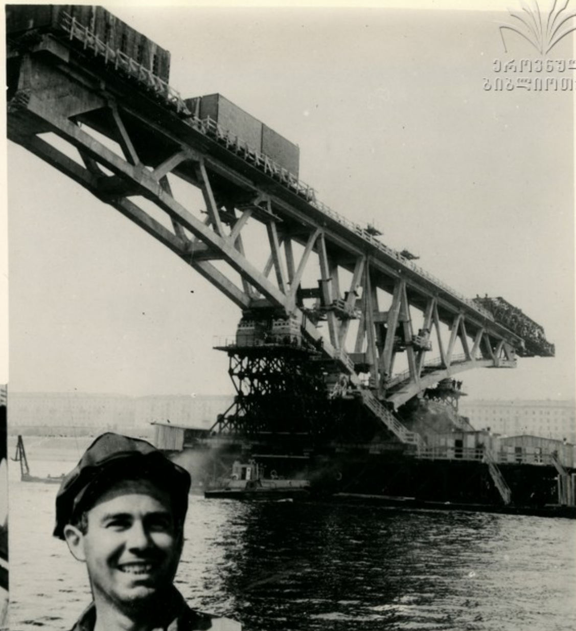
Буксирование 120-метрового блока весом 2.600 тонн по Волге к месту установки.
