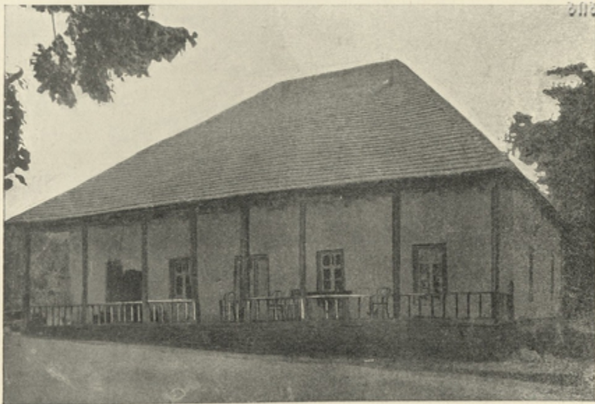
Причтовый домъ въ ингилѣйскомъ сел. Кахи. Ремонтированъ на средства Общества.
