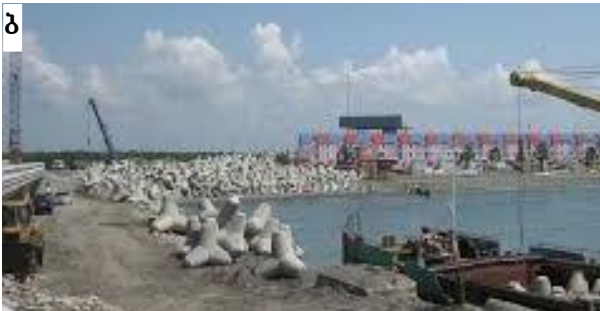
სურ. ა – ტეტრაპოდები მდ. ლიახვზე; ბ – ანაკლიის ნავსადგურში (საქართველო)
