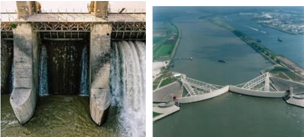
სურ. ჰიდროტექნიკური საკეტები: ა) ბრტყელი (ზაპესი, საქართველო); ბ) სემენტური (პოლანდია).
