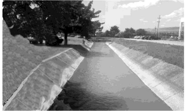
სურ. ბეტონის ფილებით მოპირკეთებული არხი
