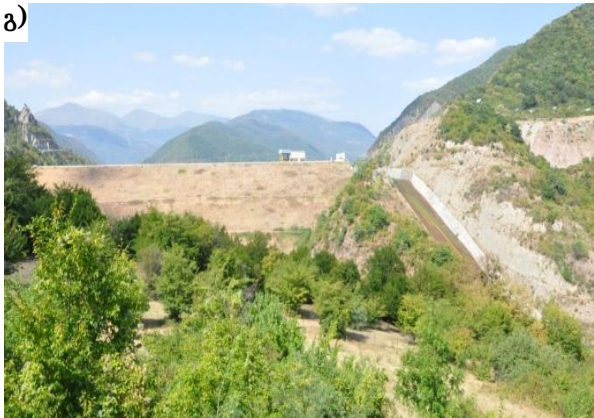
სურ. ჰიდრომშენებლობაში გამოყენებული წყალსაშვების ტიპები: ა) სამკუთხა; ბ) ტრაპეციული; გ) პრაქტიკული პროფილის კატასტროფული წყალსაშვი ფინგალის წყალსაცავზე (ხედი ქვედა ბიეფიდან).
