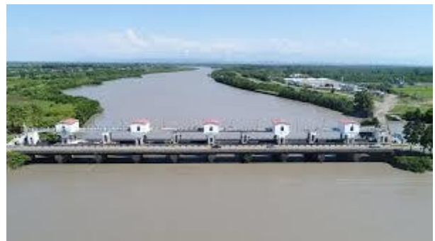
სურ. წყალგამყოფი კვანძის საერთო ხედი მდ. რიონზე
