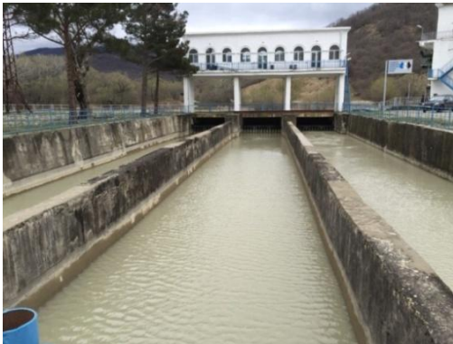
სურ. 6.4. მდ. იორზე სათავე ნაგებობა (საგარეჯოს რაიონი, სოფ. პალდო): ა) წყლის გადაღინება პრაქტიკული პროფილის წყალსაშვზე; ბ) წყალმიმღები კვანძის საერთო ხედი; გ) სამკამერაიანი სალექარის საერთო ხედი; დ) შემაუღლებელი ნაგებობის საერთო ხედი
