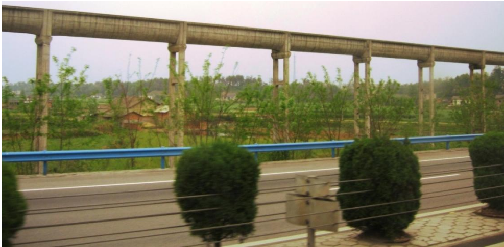
სურ. 6.1. აკვედუკის საერთო ხედი (ცენტრალური ჩინეთი, ჰუბეის პროვინცია, აეტორის ფოტო. 2014 წლის 1 ივნისი)
