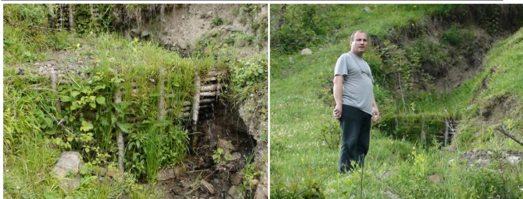
სურ. 16.13. ეროზირებული ნაწილაკებით შევსებული ბარაჟის ზედა ბიეფის საერთო ხედი (2010 წლის 30 ივლისი)
