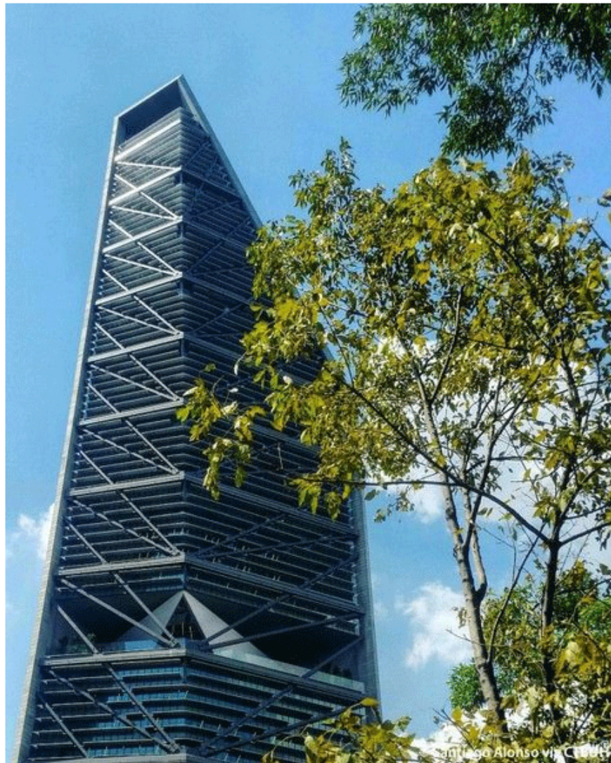
სურ. 10. Torre Reforma, Mexico City, მექსიკა
