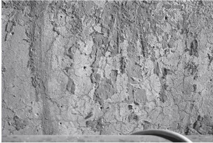
სურ. 1. საღებავის აქერცილი ფენა ჯვარცმის სცენიდან – რესტავრაციამდე. დერჩის წმ. იოანე ნათლისმცემლის სახ. ეკლესია, XVII ს-ის მოხატულობიდან
