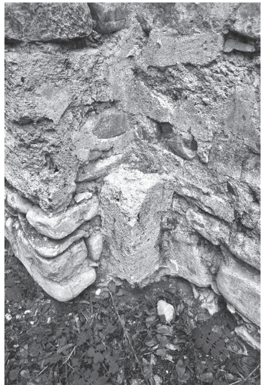
სურ. 7. წმ. იოანე ნათლისმცემლის ეკლესია. მთავარი ეკლესია. ინტერიერი. ჩრდ.-დას. კუთხე. კედლის თაღის საყრდენი საფეხურის ნაწილი, რომელიც პილასტრზე მოგვიანებითაა მიდგმული
