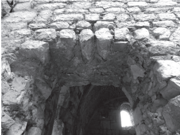
სურ. 5. ეკლესიის ინტერიერი, გარღვეული დასავლეთი კედელი რესტავრაციამდე, 2011 წლის ფოტო
