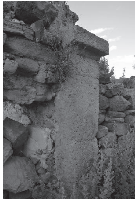
სურ. 7. ახალციხე, ღმრთისმშობლის ეკლესია, ამოქოლილი კარი და პილასტრი ეკლესიის ჩრდილოეთ კედელზე
