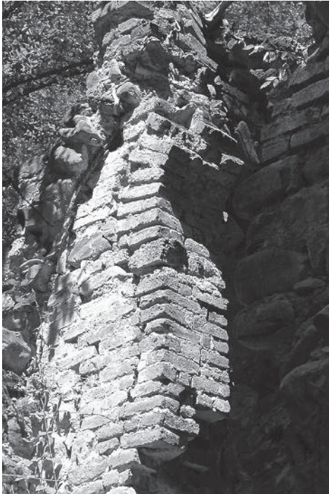
სურ. 11. წმ. იოანე ნათლისმცემლის ეკლესია. პატრონიკეს სამხრეთი სათაფლის კამარის ნაშთი ცენტრალური ნაწილის სამხრეთ კედელზე
