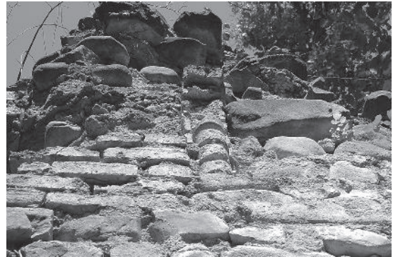
სურ. 18. წმ. იოანე ნათლისმცემლის ეკლესია. მთავარი ეკლესიის სამხრეთი ფასადის დასავლეთი მონაკვეთი. თაღის საყრდენი ლილვის ნაწილი
