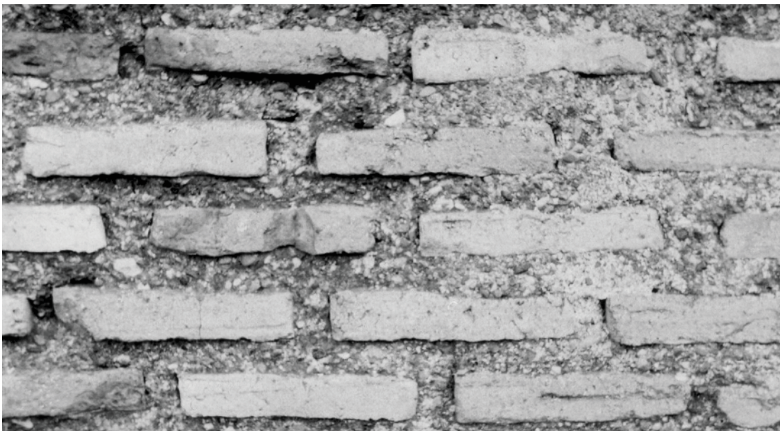
სურ. 7. სხალტბა. პირვანდელი აგურის წყობა აღმოსავლეთ ფასადზე.
