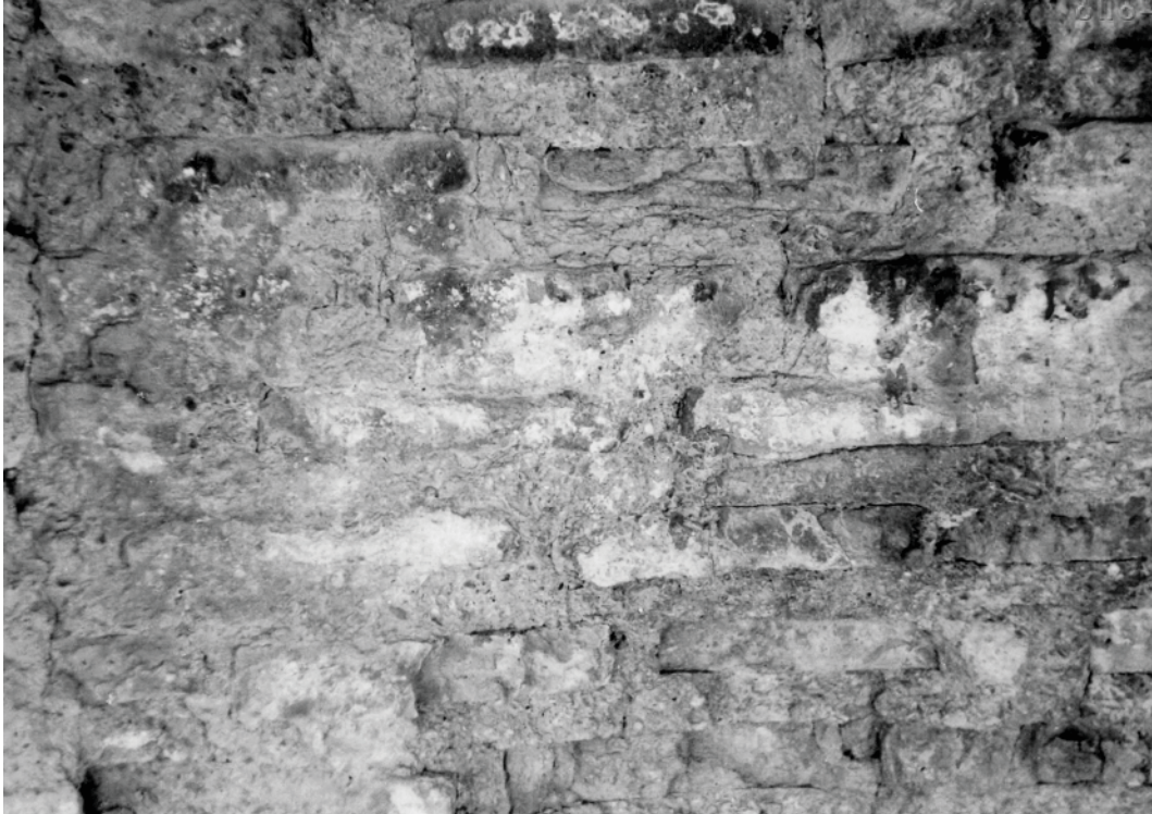
სურ. 10. სხალტბა. მეორადი წყობა ეკლესიის სამხრეთ ფასადზე.
