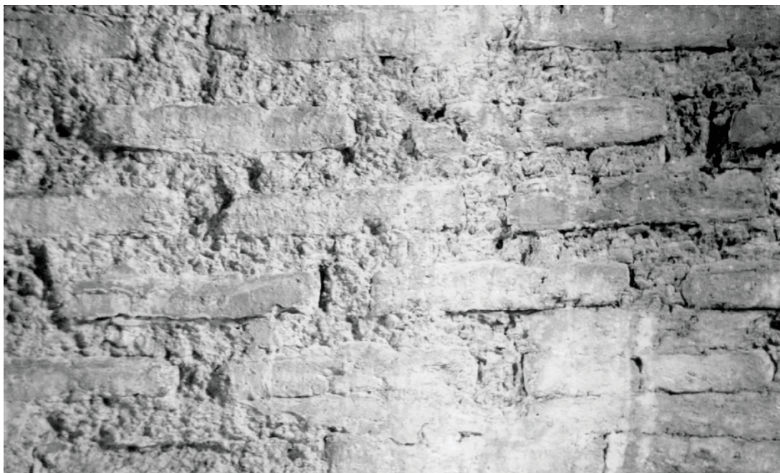
სურ. 9. სხალტბა. მეორადი წყობა ეკლესიის შიგნით ჩრდილოეთ კედელზე.
