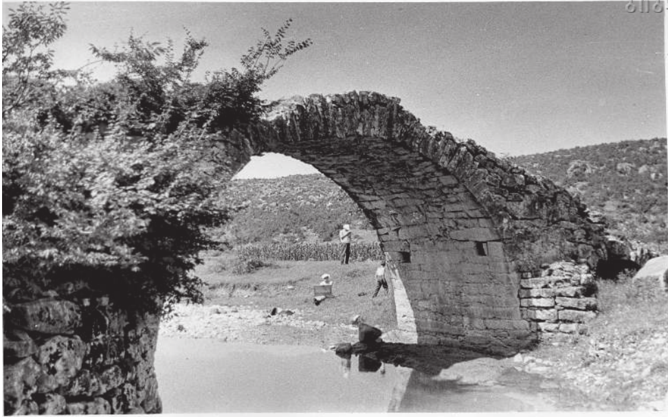
სურ. 7. ჭიშურას ხიდი. საერთო ხედი
