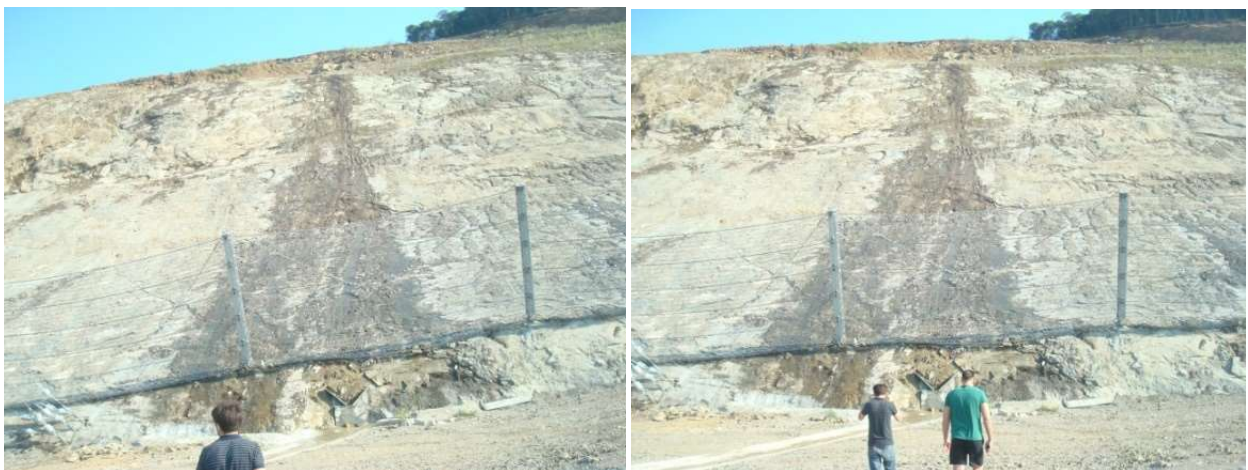
ნაპრალო წყალგამოვლინება დატერასებული ფერდობის ზედაპირზე
