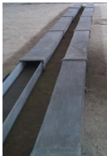
ნახ.1. ფიბრობეტონის საკაბელო არხი
