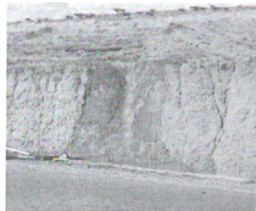
ფოტო 4. II საკვლევი უბანი — დასაბეტონებლად მომზადებული, გაწმენდილ მდგომარეობაში
