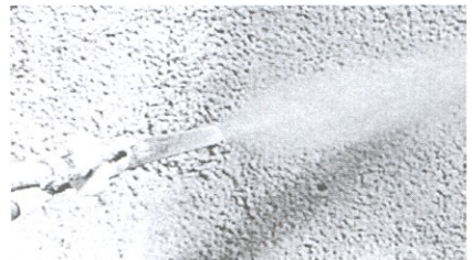
ფოტო 8. დასაბეტონებელ ზედაპირზე ბეტონის წნევით დატანა
