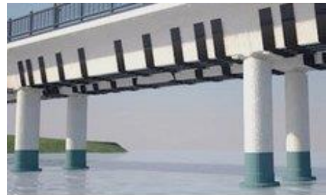
სურ. 1. რკინაბეტონის კონსტრუქციის გარე დაარმირება
