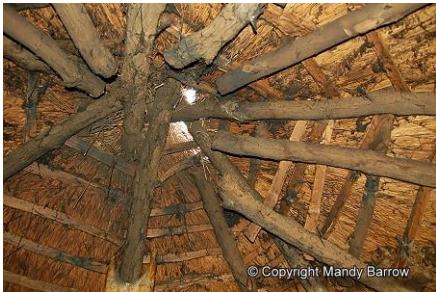
სურ. 2. ლითონის ხანის საცხოვრისის გადახურვის სტრუქტურა
