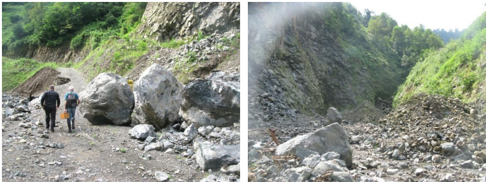
სურ. 1. მდ. კინკიშის კალაპოტში ქვის მოპოვების შემდგომ დატოვებული ლოდნარი (მარცხნივ) და ინერტული მასალა (მარჯვნივ)
