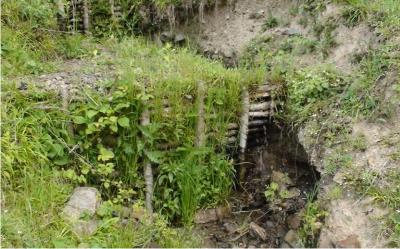
სურ. 3.5. ეროდირებული ნაწილაკებით შევსებული ბარაჟის საერთო ხედი (2010 წლის 30 ივლისი)
