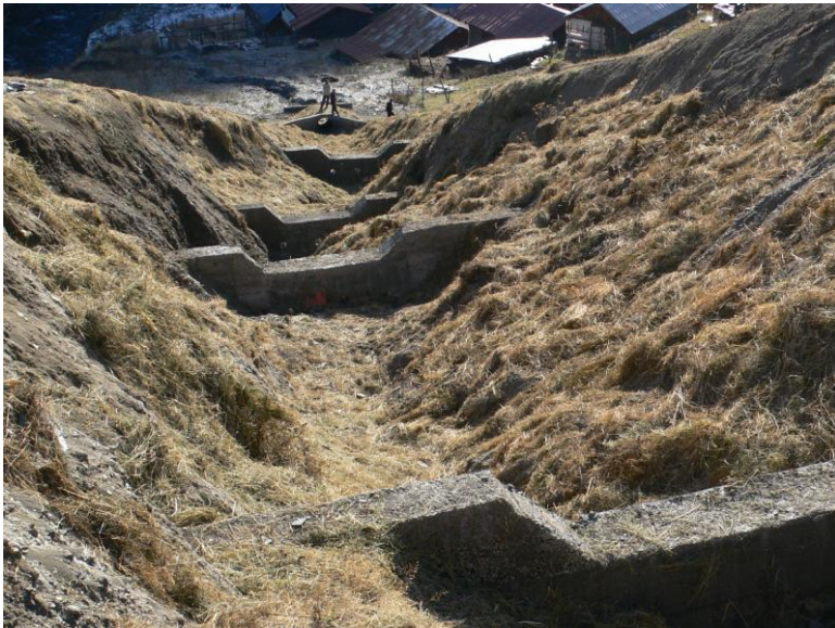
ნახ. 4.3. ეროზიის საწინააღმდეგო ბეტონის ბარაჟები. მთათუშეთი. 2007 წლის 21 ნოემბერი
