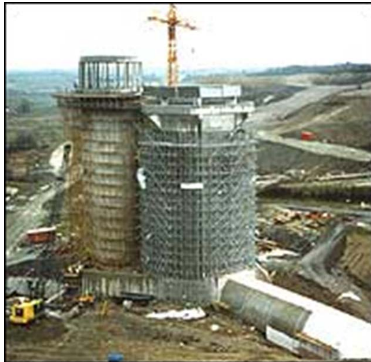
შახტური წყალსაგდები კომპი მშენებლობის დროს Roadford Dam in Devon, SW England.
