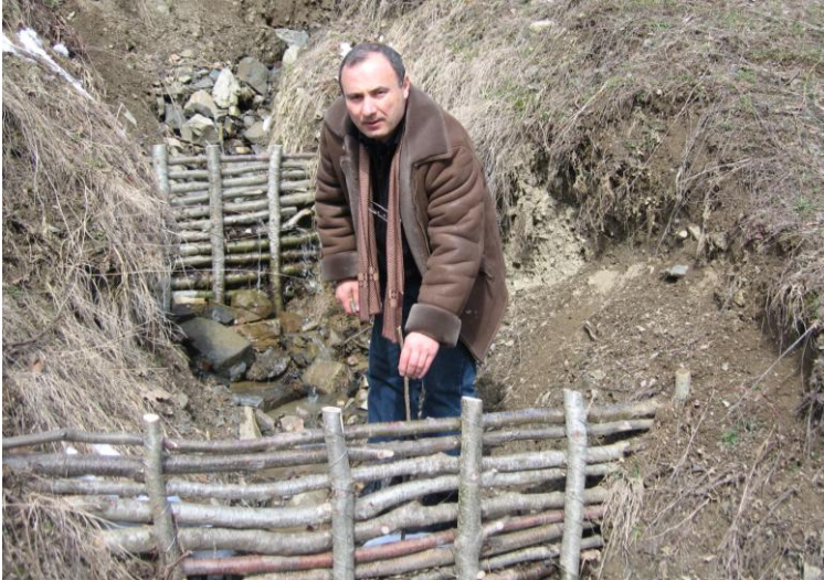
ფოტო 81. შეუვსებელი ბარაჟის საერთო ხედი (2008 წ.). Photo 81. General view of unfilled barrage (2008). Фото 81. Общий вид незаполненного барража (2008 г.).
