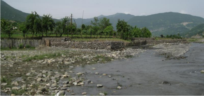
ფოტო 83. ქვის დეზები მდ. ცხენისწყალზე Photo 83. Stone spurs on the River Chxenistskali Фото 83. Каменные шпоры на р. Цхенисцкали
