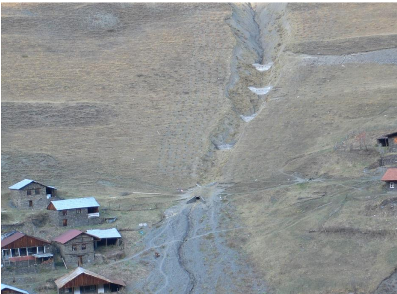
ფოტო 10. სოფ. ჯვარბოსელში (მთათუშეთი) ეროზიის საწინააღმდეგო კაშხლები Photo 10. Antierosion dams at village Dzhvarboseli Фото 10. Противозрозионные плотины у с. Джварбосели (Мтатушети)
