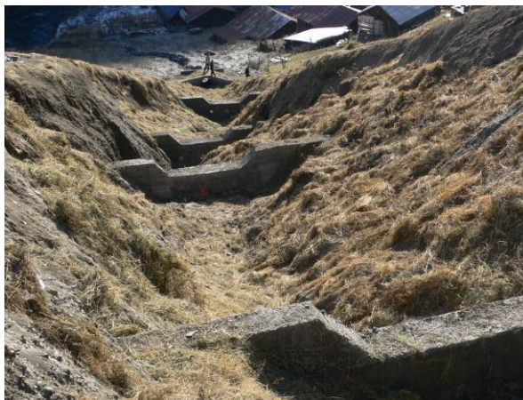
ფოტო 78. ეროზიის საწინააღმდეგო ბეტონის ბარაჟები. 21.11.2007 Photo 78. Concrete barrage construction against erosion. 21.11.2007 Фото 78. Противозерозионные бетонные барражи. 21.11. 2007
