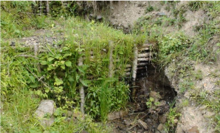
ფოტო 82. ეროზირებული ნაწილაკებით შევსებული ბარაჟის საერთო ხედი (2010, 30 ივლისი) Photo 82. General view of barrage completed by eroded particles (30 July, 2010) Фото 82. Общий вид барража, заполненного эродированными частицами (30 июля 2010 года)
