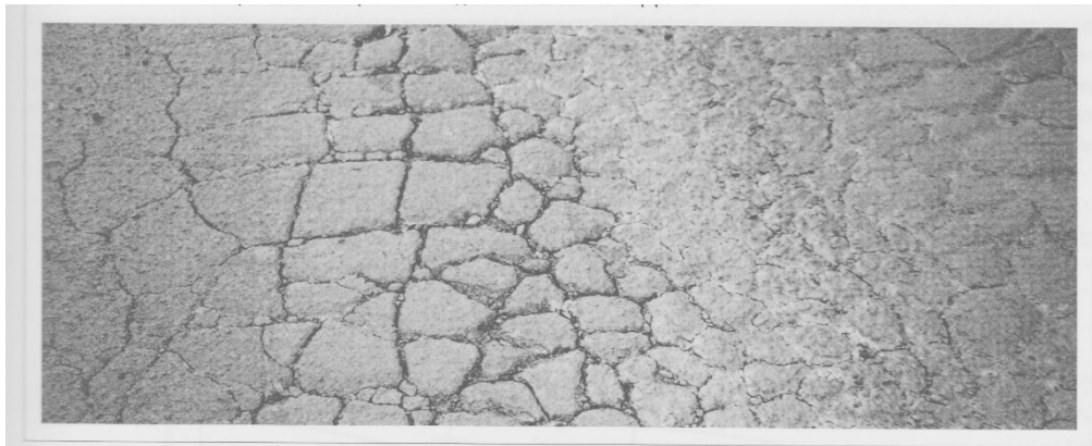
ნახაზი 4. საფარის ტიპიური დაზიანებები „სატუმბო“ ეფექტის შედეგად
