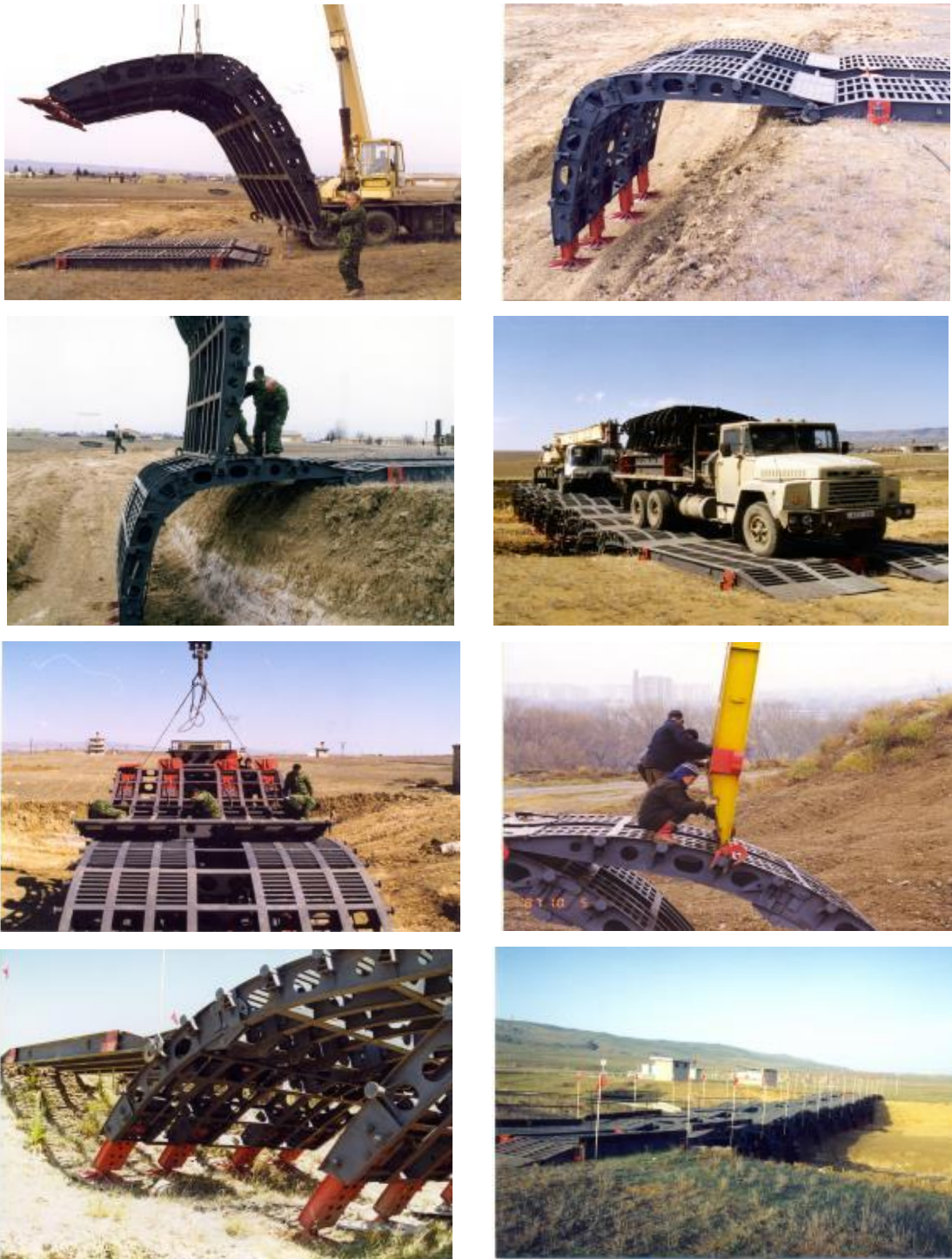
ფიგ. 18 – სწრაფადსაგები ინვენტარული ხიდის KM-02T-ის აწყობის ეტაპები
