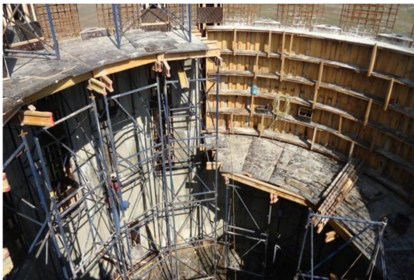
სურ.3. ნახევრადწრიული ყალიბის გადაადგილება და დაფიქსირება
