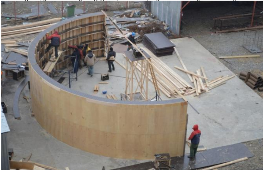
სურ.2. ნახევრადწრიული ყალიბის აგება სადურგლო საამქროში
