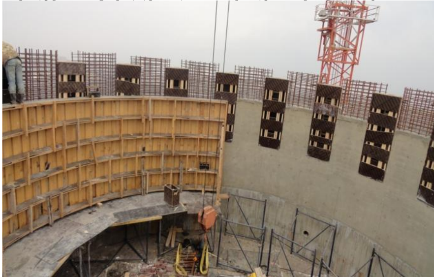
სურ.4. დიდღიობიანი სარკმლების მოწყობა ნახევრადწრიული ყალიბით
