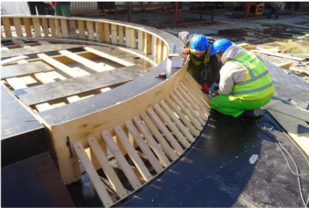
სურ.1. მარტივი თაღის მოსაწყობი ყალიბის აგება სურ.2. ყალიბის აგება სამკუთხა ჩარჩოებით
