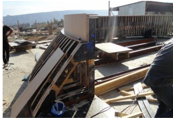
სურ.1. მარტივი თაღის მოსაწყობი ყალიბის აგება სურ.2. ყალიბის აგება სამკუთხა ჩარჩოებით
