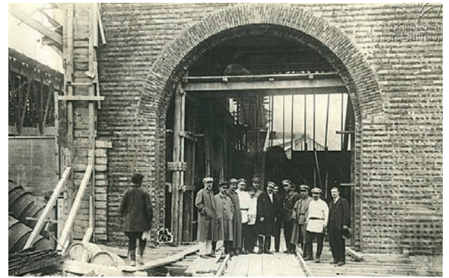
სტალინი ზაჰესის მშენებლობაზე. ფოტო - ციფრული ბიბლიოთეკა ივერიელი STALIN AT ZAHESI CONSTRUCTION. PHOTO - DIGITAL LIBRARY IVERELI
