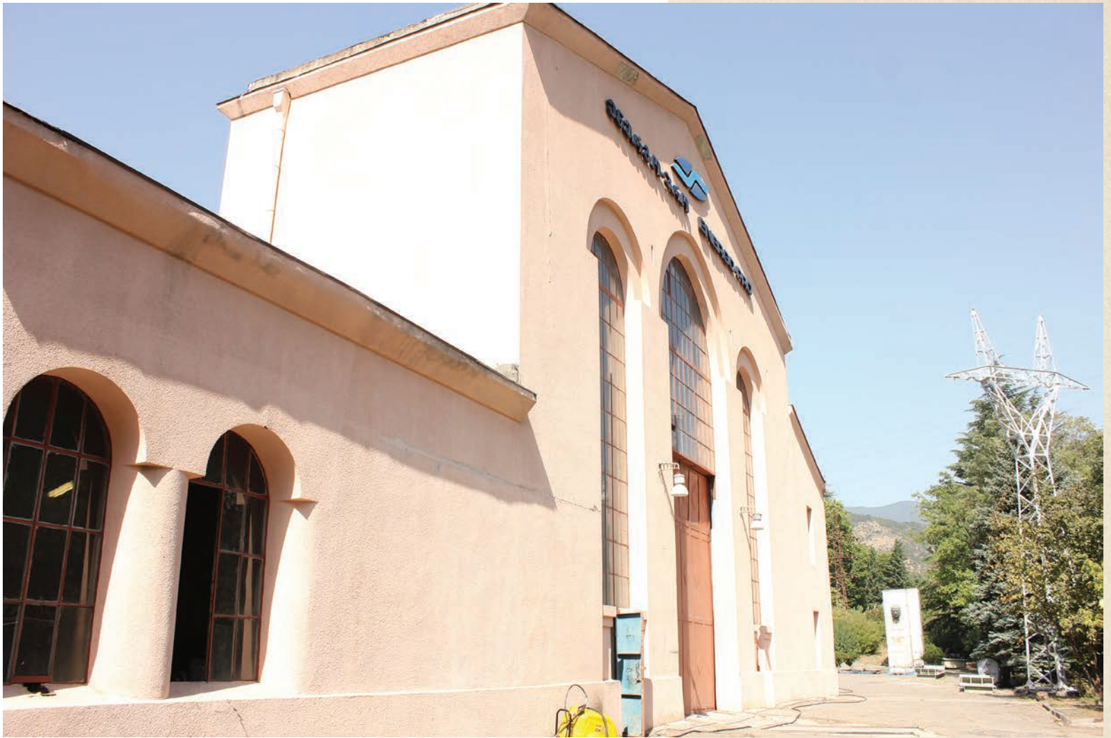
ზაჰესის სადგურის შენობა. მცხეთა ZAHESI POWER STATION BUILDING. MTSKHETA
