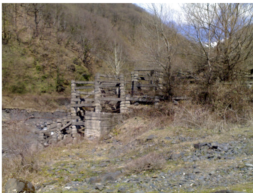
ნახ.1. ი.ხერხეულიძის ცხავური ტიპის სელდამჭერი ნაგებობა
