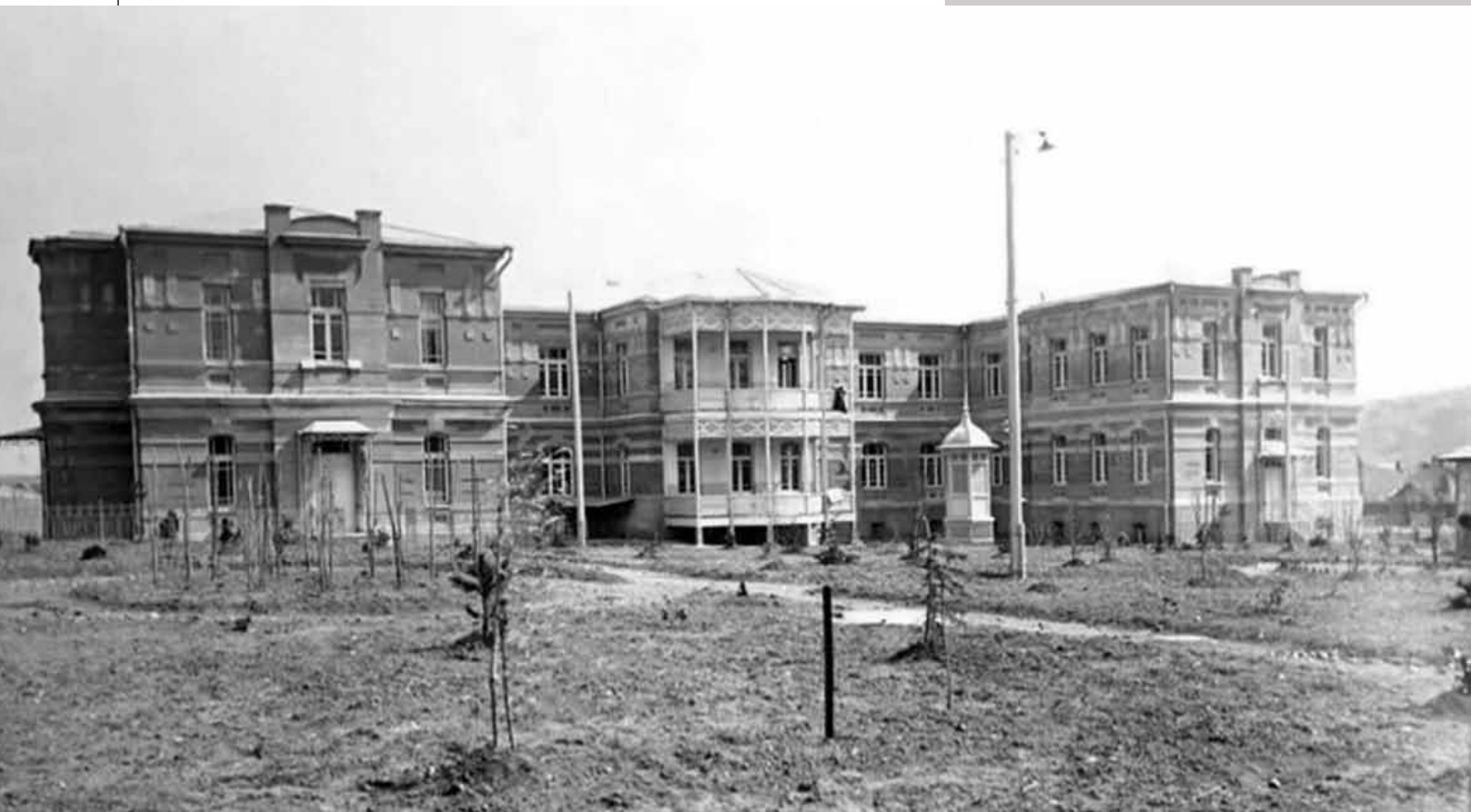
Двор больницы Арамянца во время ее строительства. 1909
