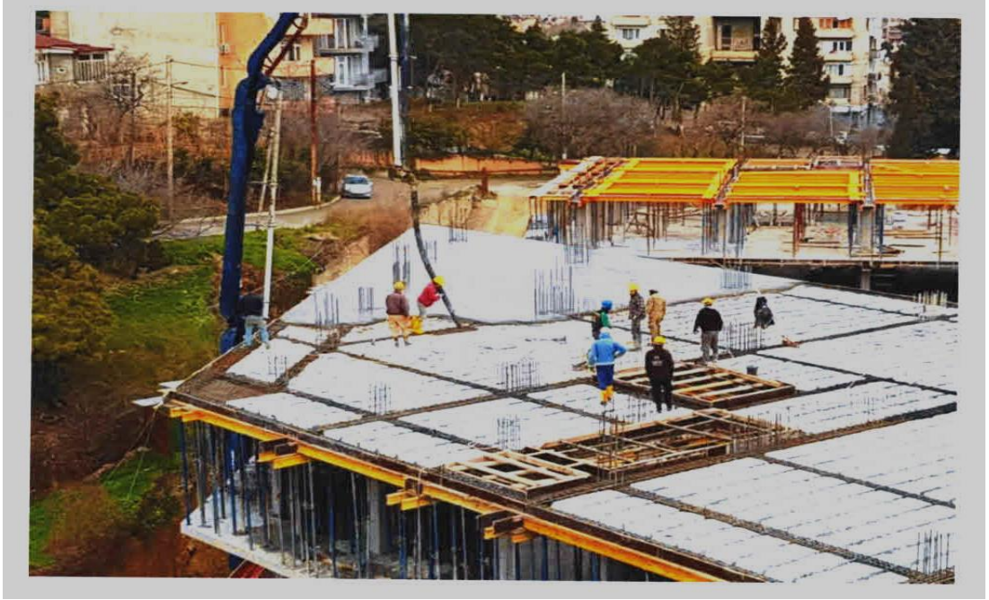
სურათი 4.2.1. ასაწყობი მონოლითური გადახურვა, კრწანისი
