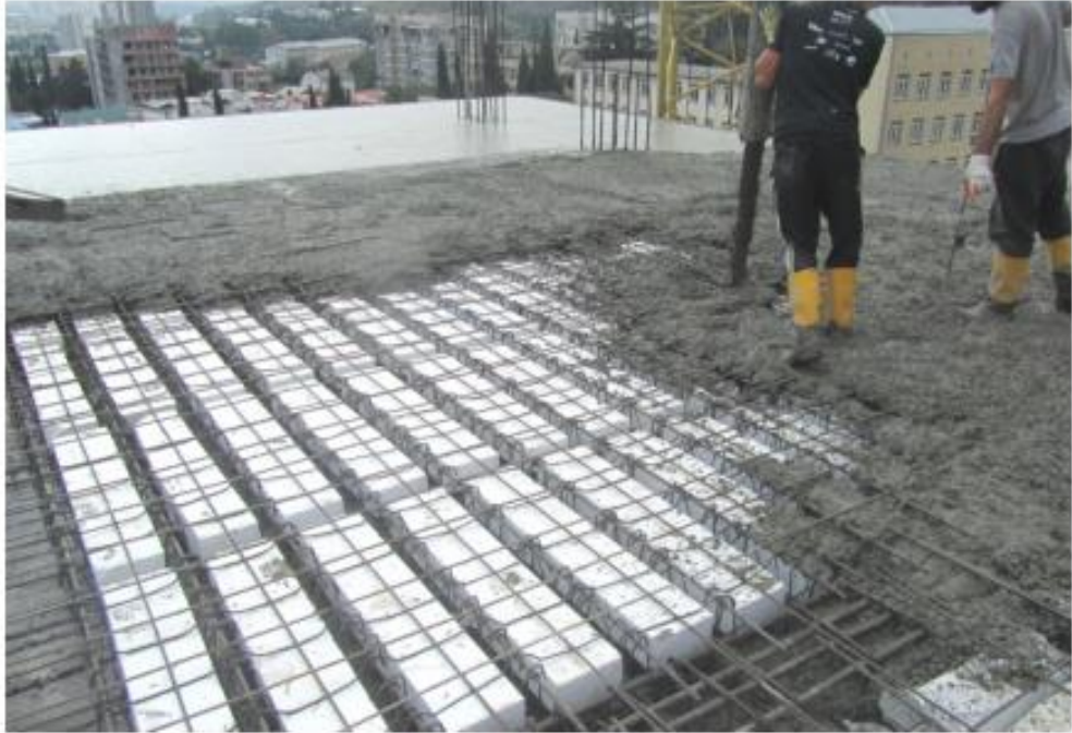
არმატურის კარკასი თბოიზოლირებული ფილისთვის, კრანისი
