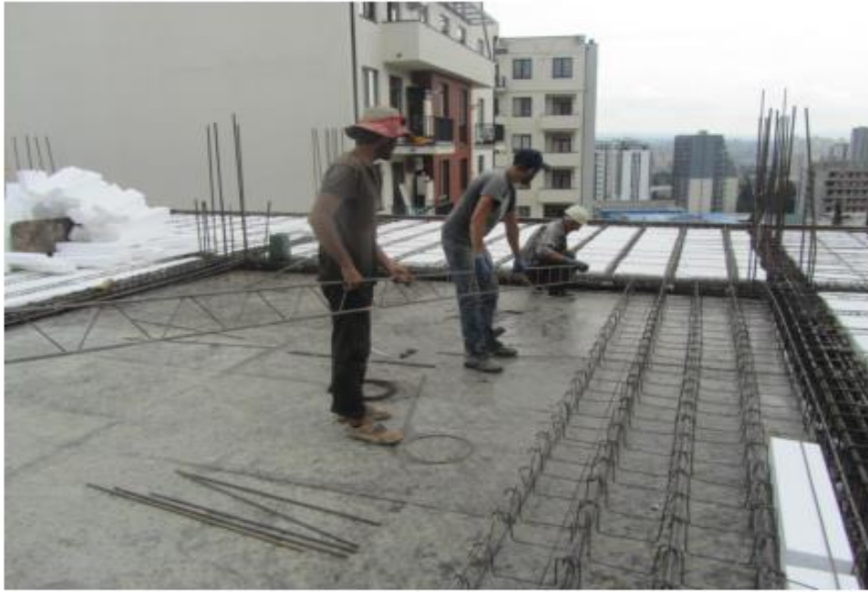
არმატურის კარკასი თბოიზოლირებული ფილისტონის, კრწანისი
