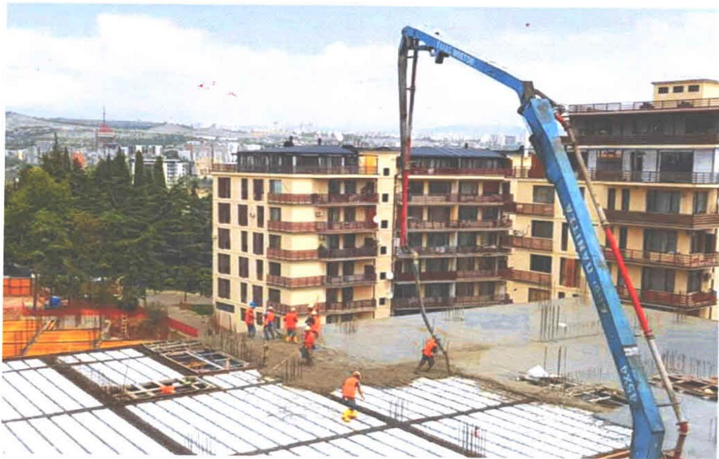
სურათი. 3.4.2.2 საცხოვრებელი სახლი №2 „პომპის“ მუშაობის პროცესი დაბეტონებაზე
