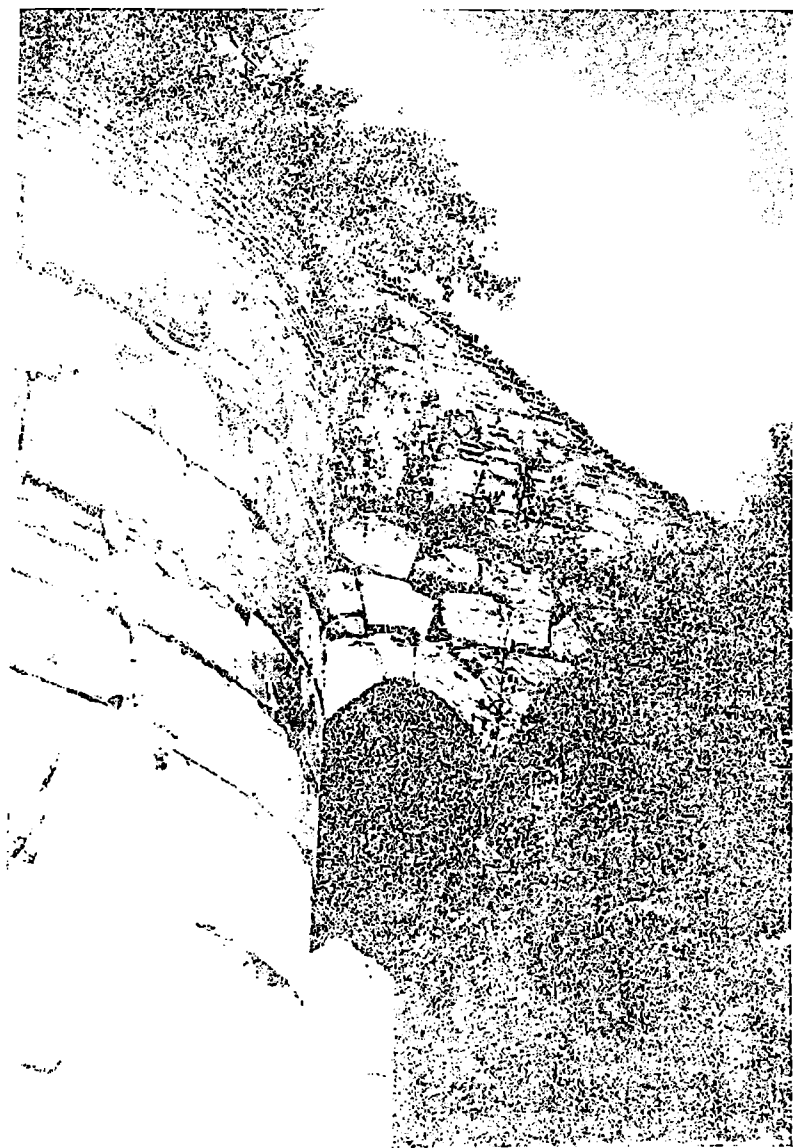
Рис. 83. Часть починенной стены северного придела и арка, соединявшая кровли.
