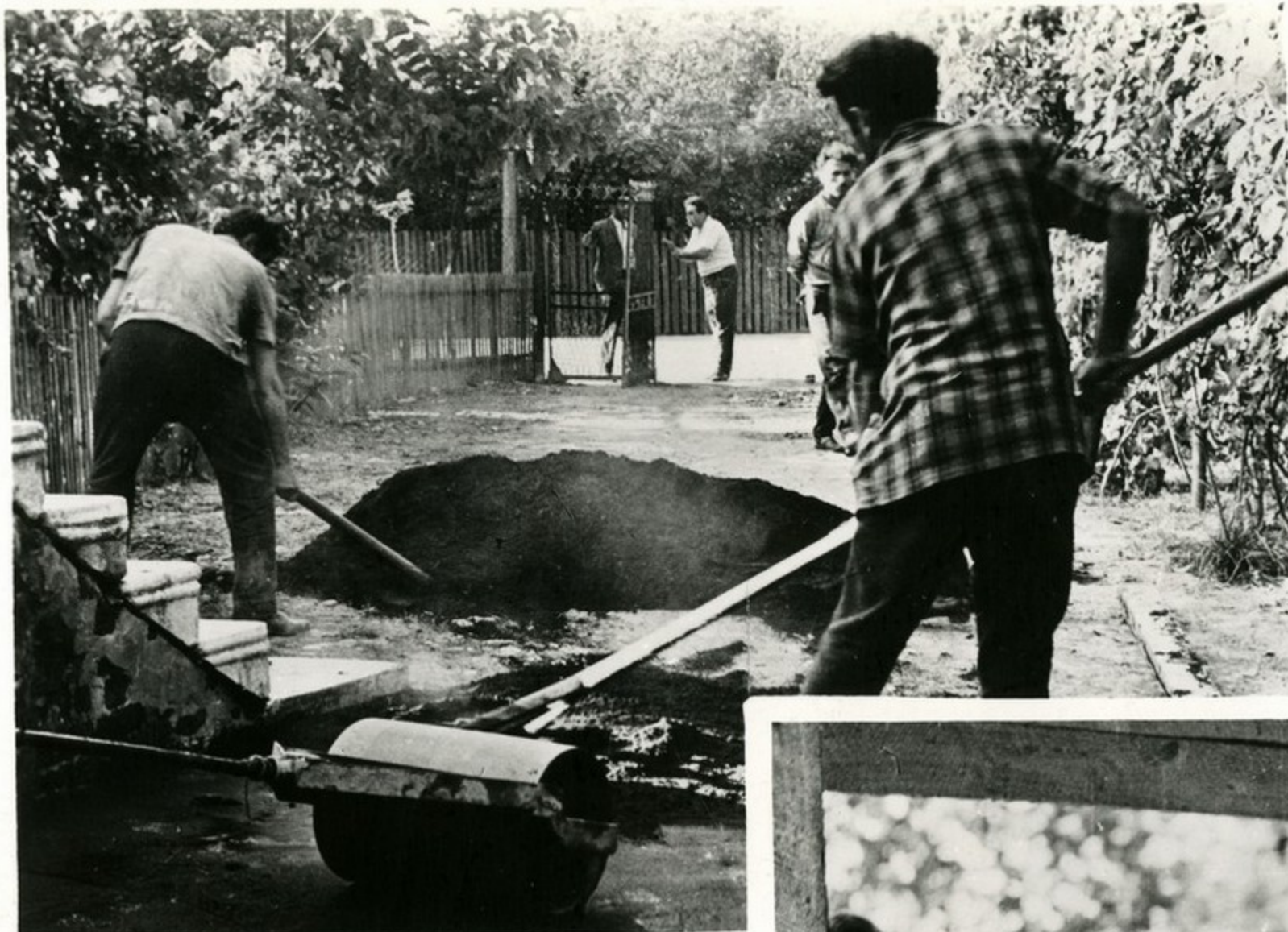
Асфальтировка дорожек в Тетрицкаройском районе.
