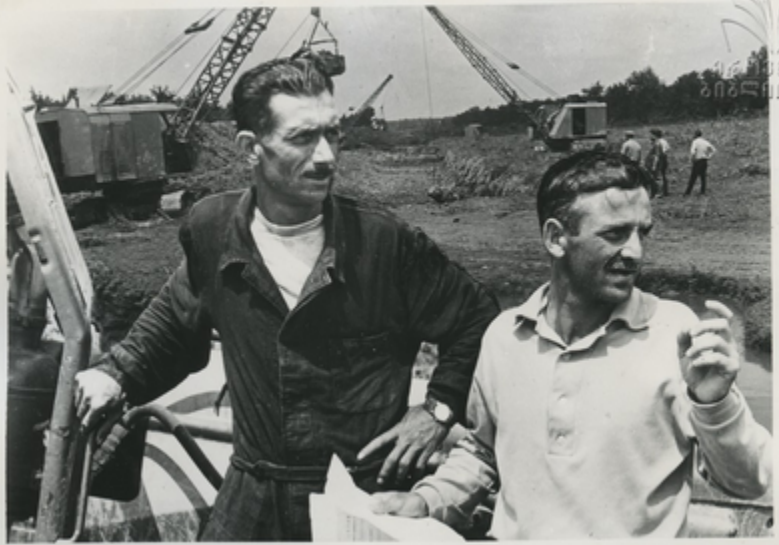
Идут работы по осушению Колхидской низменности. Техник Лавчухтского участка механизации Б. Квласония (справа) и бульдозерист Д. Хурция.
