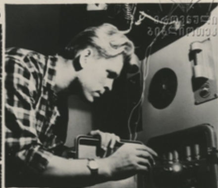
Техник В. Логинов налаживает прибор для анализа газовой среды.
