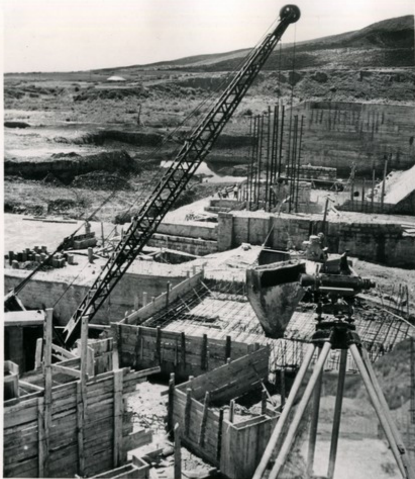
Общий вид строительства головного сооружения Нижне-Самгорской оросительной системы
