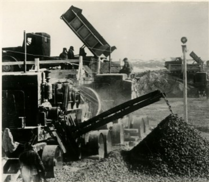
На строительстве „Дороги дружбы“.
