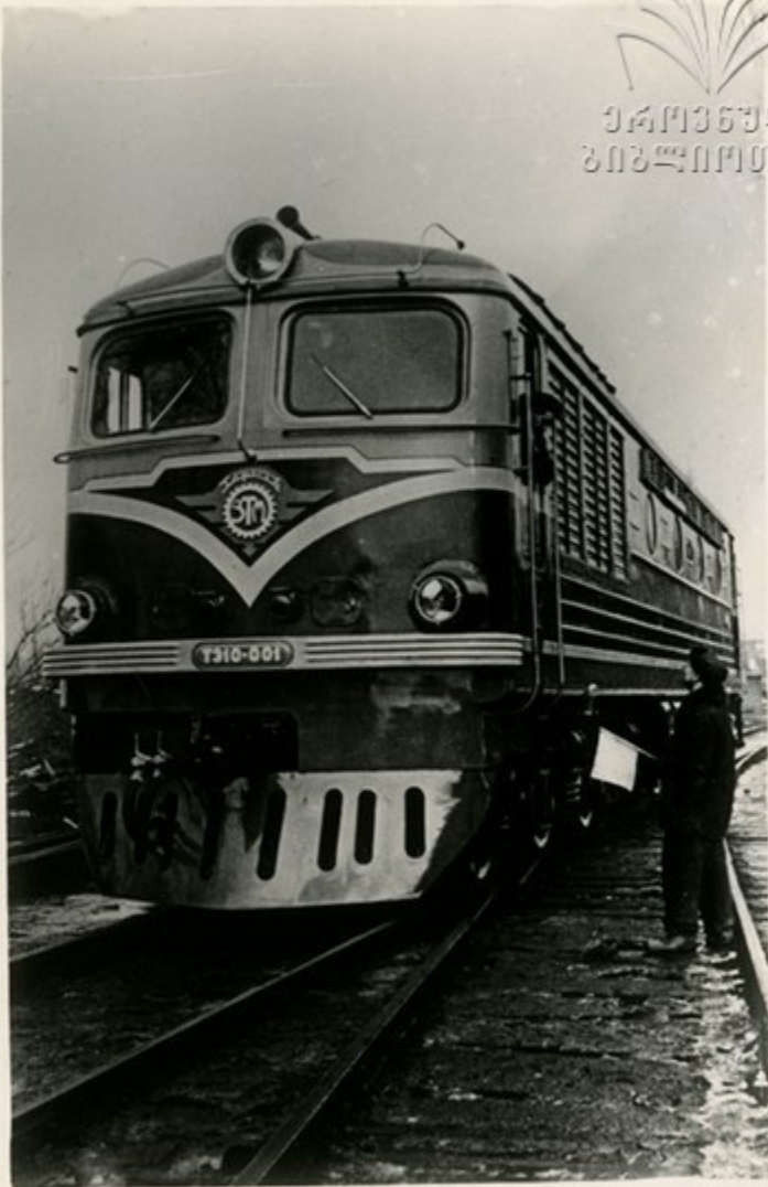
Тепловоз ТЭ—10. Мощность—3.000 лошадиных сил в каждой секции.
