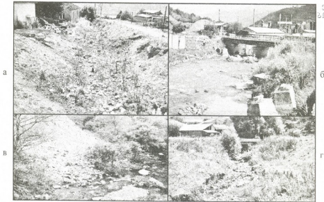
Рис. 2. Свалки строительного и бытового мусора в руслах рек и мелких водотоков (а, б, в) и место возможного подпора воды перед мостовым переходом (г) (фото В.Р.Бойнагряна)
