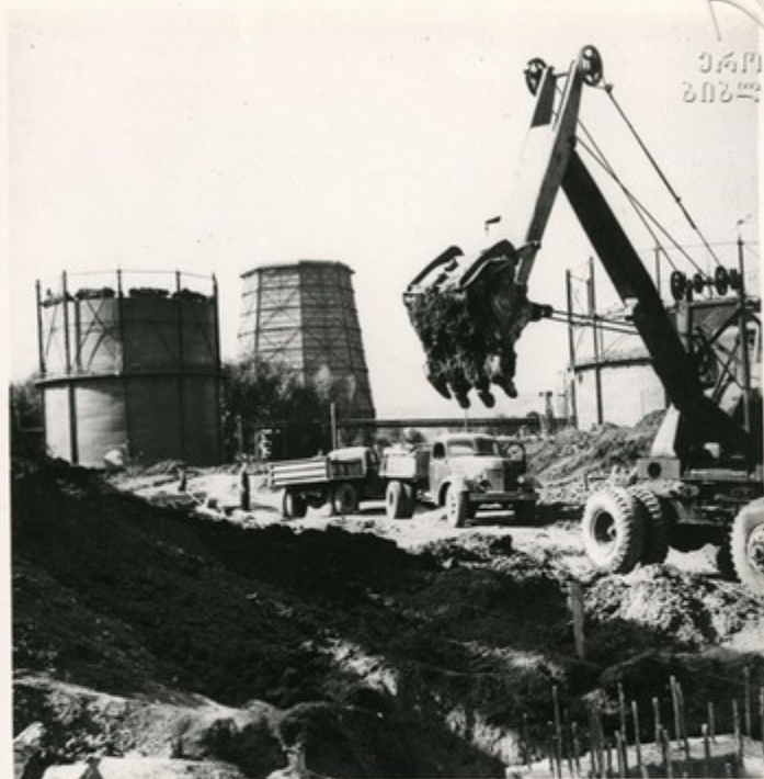
Строительство цеха карбамида
