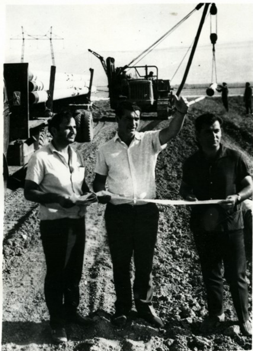
На снимках: прокладка магистрального газопровода в сторону Цхинвали.
