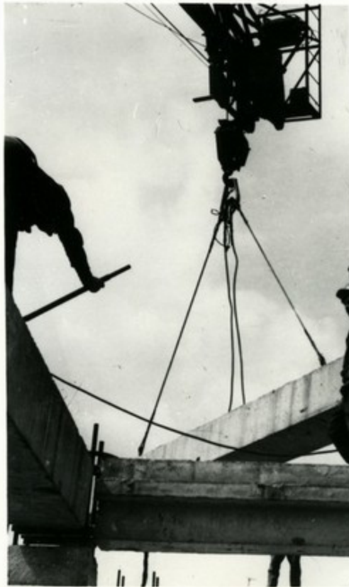
Строительство жилого дома.
