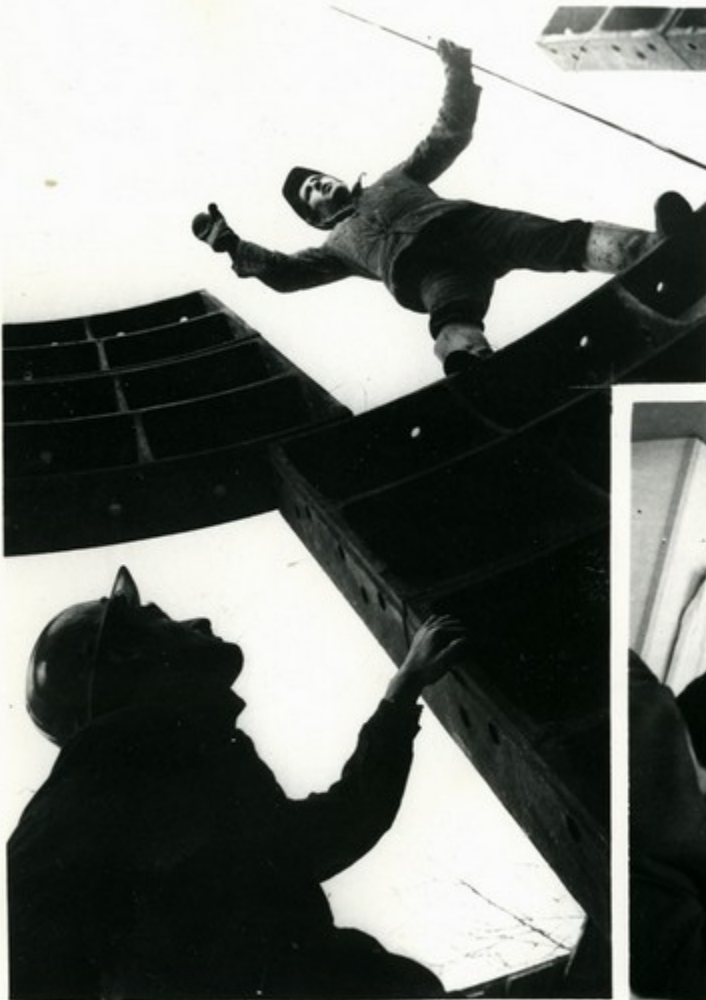
Прокладка новой магистрали
