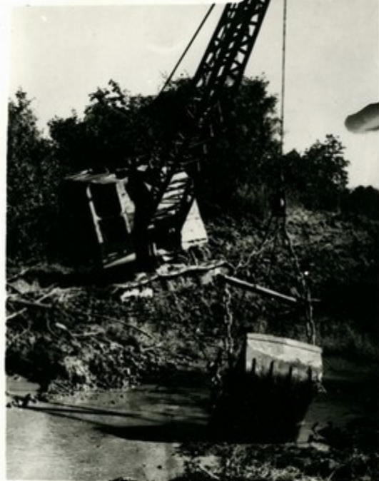
Экскаватор прокладывает собирательный канал в Колхидской низменности
