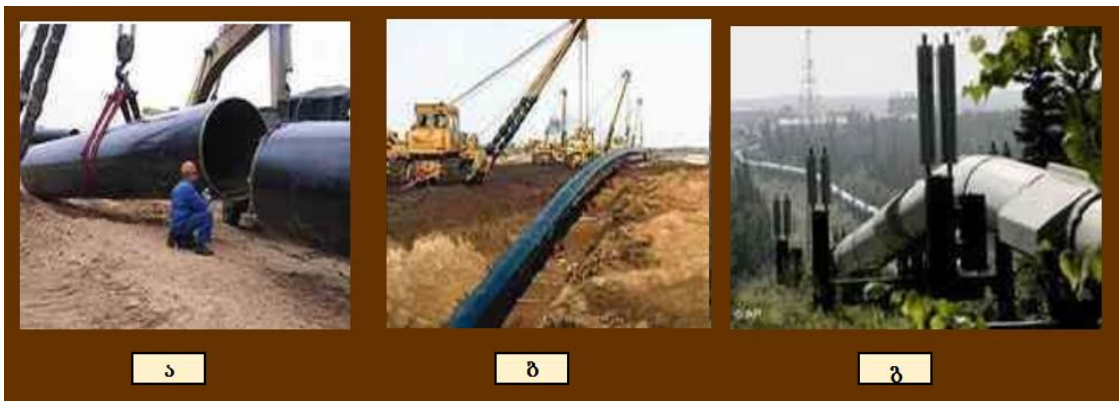
ნახ. 40. მაგისტრალური ნავთობსადენი: ა. მშენებლობა; ბ. მონტაჟი; გ. ექსპლუატაცია
