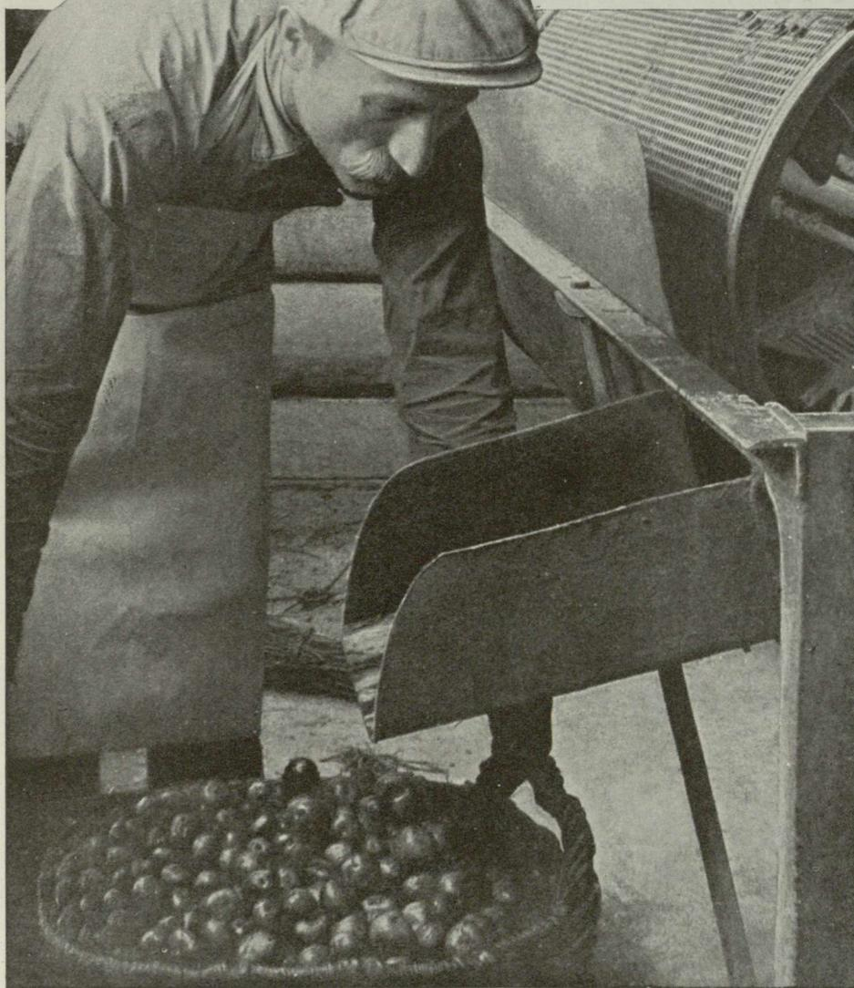
Картофелемойка приводится в действие также электромотором.
