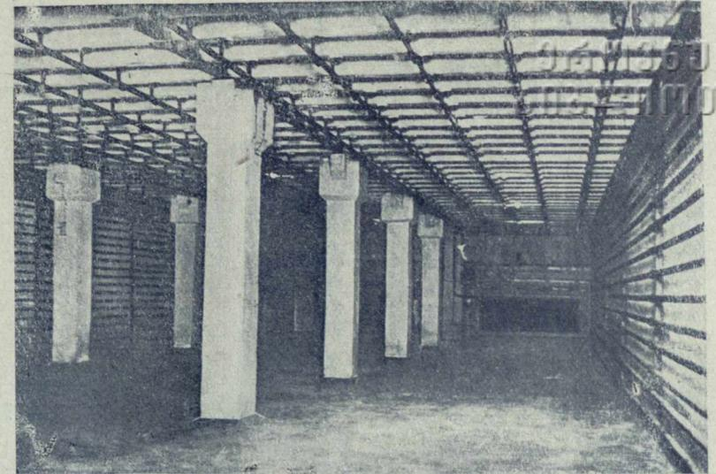
Морозильная камера с  $t^{\circ}$  охлаждения  $-23^{\circ}\text{C}$ , суточной пропускной способностью 80 тонн мяса.
