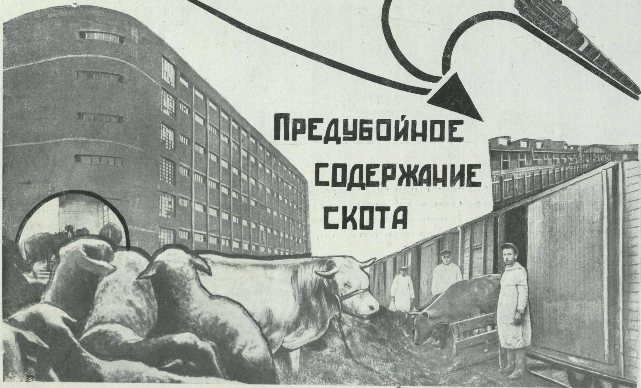
Эшелоны с поступающим скотом подаются на Комбинате к скотоприемным сооружениям. Здесь скот выгружается, подвергается предварительному ветсаносмотру, термометрируется (измеряется температура), взвешивается и подается в скотозагоны, откуда поступает в Лайф—Стаг (цех предубойного содержания скота).
