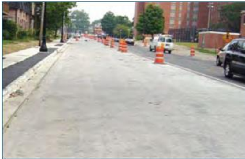
სურ. 2.3. დატკეპნილი ბეტონის საფარის მოწყობა მაგისტრალურ გზაზე
