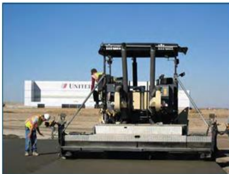
სურ. 2.2. დატკეპნილი ბეტონის საფარის მოწყობა აეროპორტში
