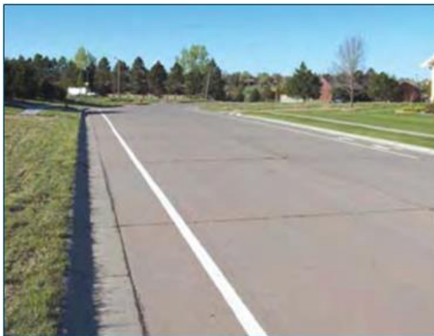
სურ. 2.4 დატკეპნილი ბეტონის საფარის მოწყობა ადგილობრივ ქუჩაზე
