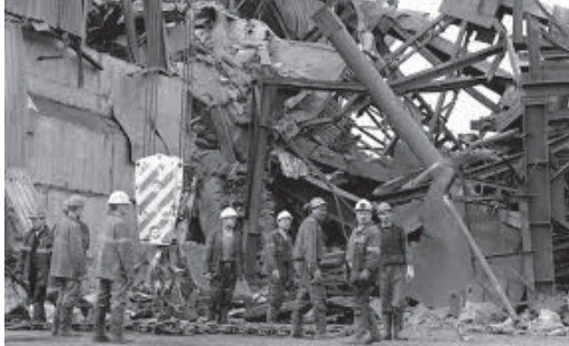
ნახ. 1. შახტის ზედაპირზე განლაგებული შენობა-ნაგებობების ნგრევის ამსახველი ფოტოსურათები კუზნეცის აუზის შახტა “რასპადსკაია”-ს წმენდით სანგრევში მომხდარი მეთანის აფეთქების შედეგად [13]
