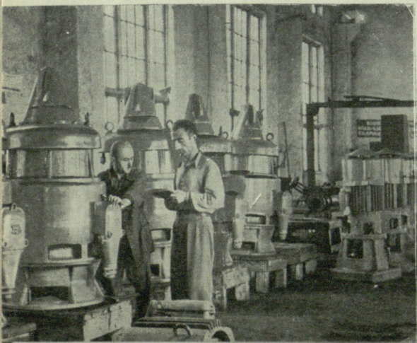
ქუთაისის ქარხანა „გორნიაკში“ დამზადებული არტეზიული დგუშები.
