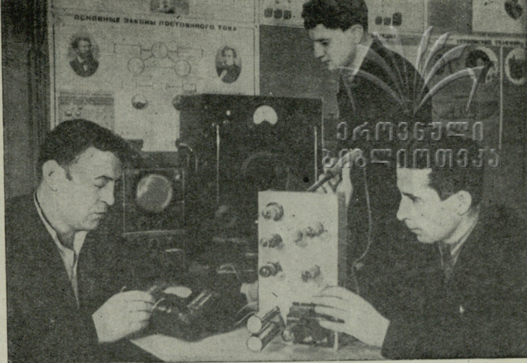
რადიოკლუბის საკონსტრუქციო ლაბორატორიაში რადიომოყვარული-კონსტრუქტორები (მარცხნიდან მარჯვნივ): იური ხუცრავილი, კოტე ხიმშიაშვილი და ლევან პავლენკო გამოფენისთვის ამზადებენ სტაციონალურ მაგნიტოფონის მაღალხარისხიან გამაძლიერებელს.
