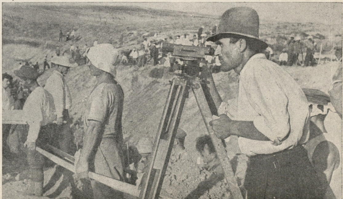
↓ ინჟინერ-ტოპოგრაფები სამგორწყალმშენის მეორე უბნის ტრასის ნიველირებაზე. ფოტო რ. აკოფოვისა
